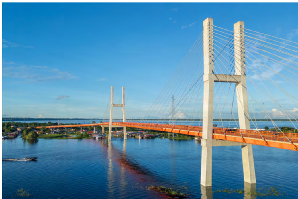
Pont Nanay, le plus long du Pérou, situé dans la ville d'Iquitos et permettant de traverser la rivière Nanay. Source : Adobe Stock Images, Gino Tuesta
