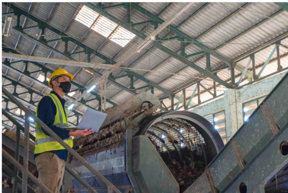
Inspector de calidad comprobando la máquina de clasificación de residuos en una planta de clasificación de residuos. Fuente: Adobe Stock Images, bird_saranyoo
