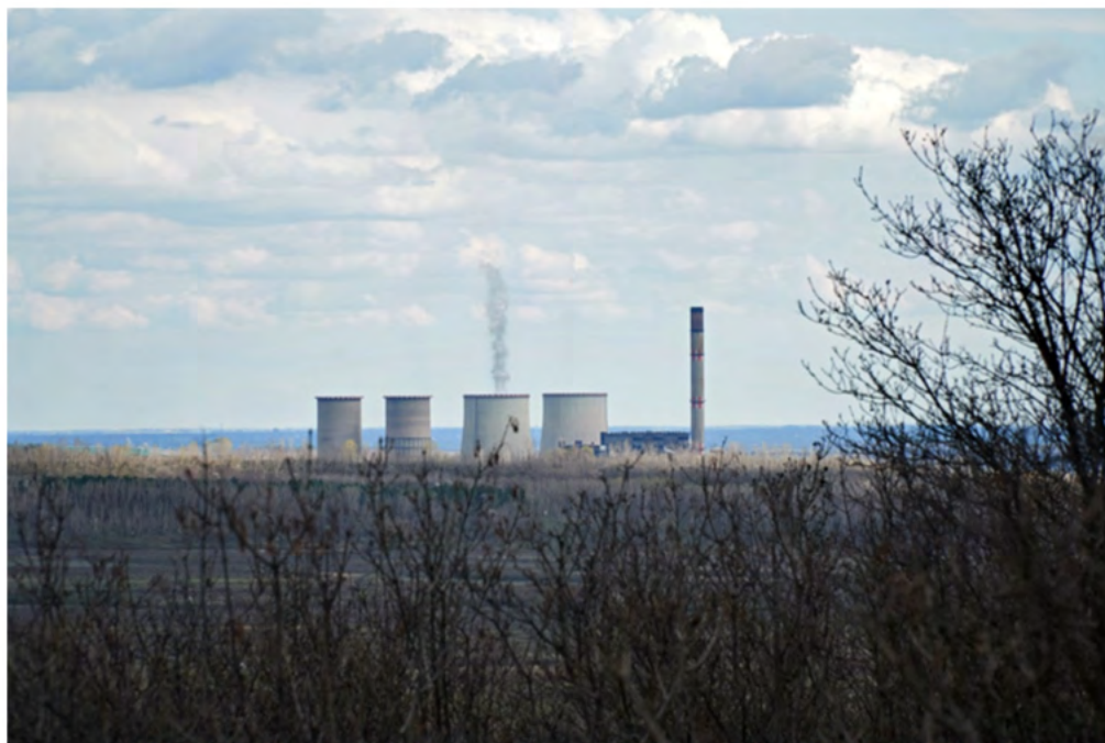
Centrale électrique à Visonta, Hongrie. Source : Adobe Stock Images, Imagenist
